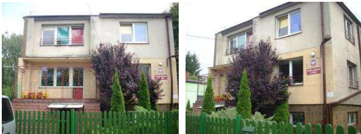
Rysunek 1 widok elewacji frontowej (południowo-zachodniej)
