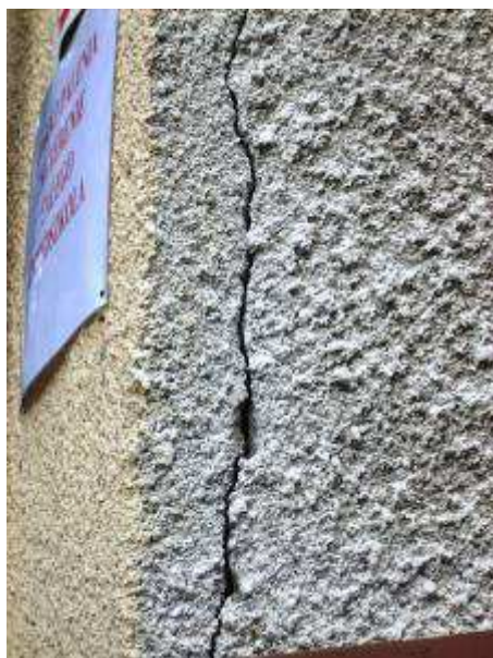
Rysunek 7 Widok fragmentów konstrukcji ściany południowej budynku dydaktycznego
