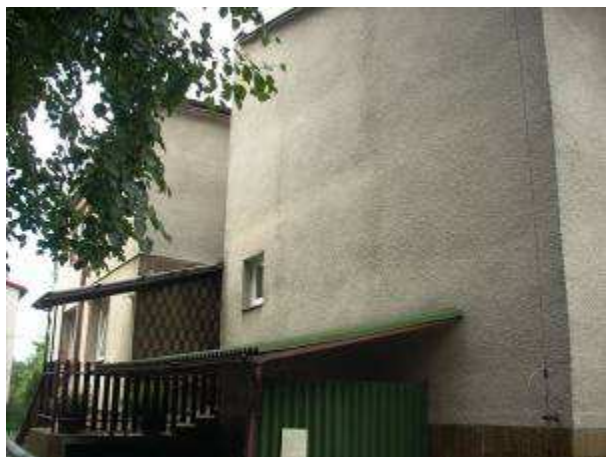
Rysunek 3 widok elewacji południowo wschodniej (wejście główne do budynku)
